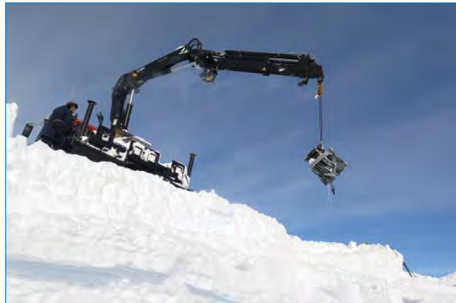
Извлечение РИТЭГа краном.
