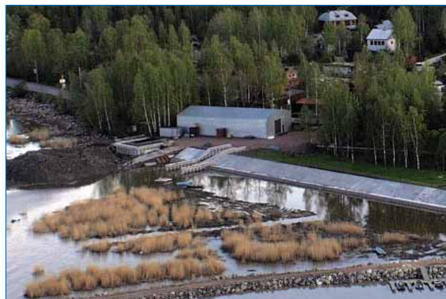
Складской комплекс со стороны Ладожского озера.
