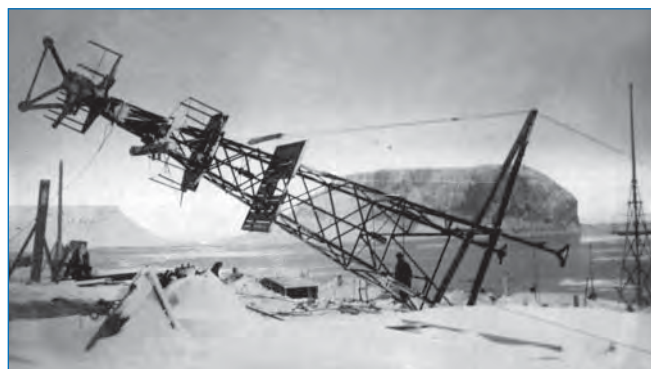
Подъем башни ветродвигателя Д-12. Фото Б.А. Кремера (РГАЭ, ф. 572, оп. 1, д. 63, л. 112).
