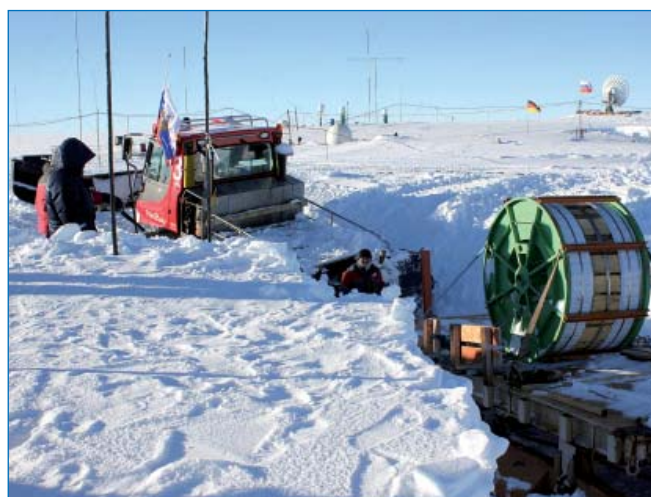
Подготовка к замене бурового кабеля.
