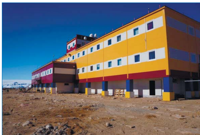
Вид служебно-жилого здания с севера.
