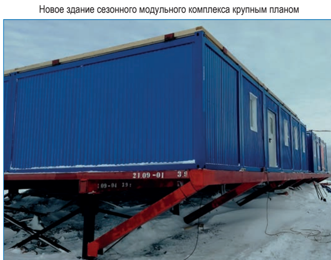
Новое здание сезонного модульного комплекса крупным планом
