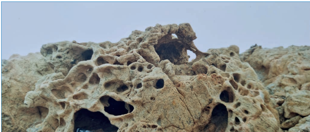
Выветривание. Станция Прогресс. 1999 год
