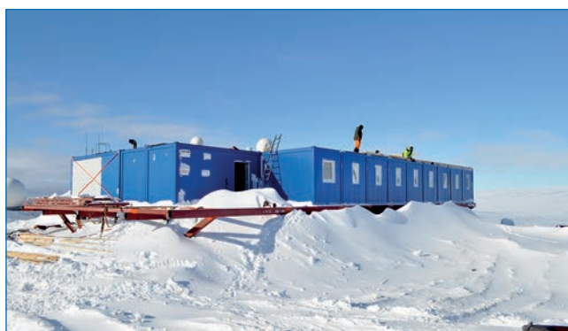
Сборка нового модульного служебно-жилого здания на станции Мирный. Фото И.И. Саввы
