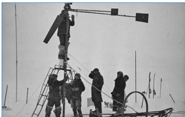
Установка ветряного двигателя в полярном лагере
