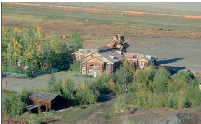
Здание аэропорта в пос. Сеймчан. Фото Д.В. Ульянкина
