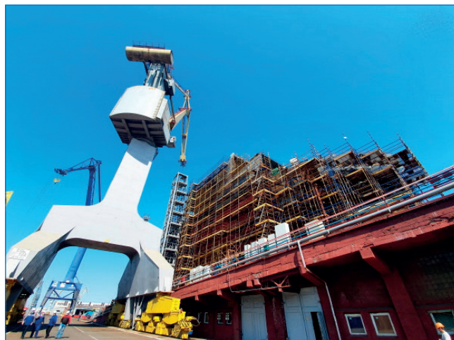
Корпус ЛСП «Северный полюс»
