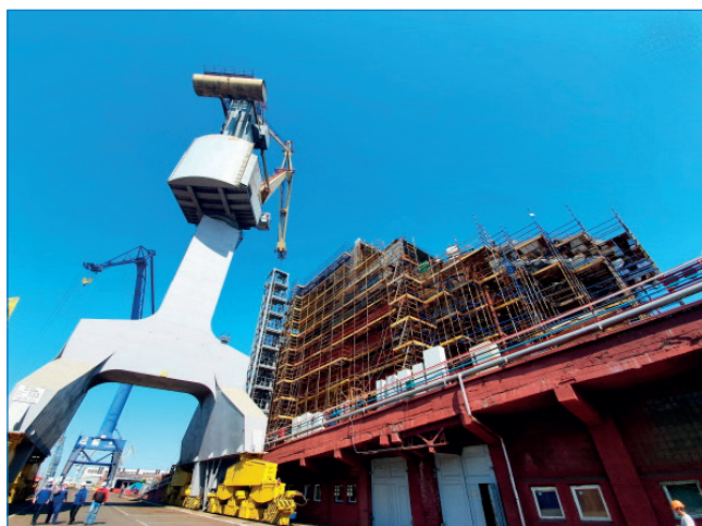
Корпус ЛСП «Северный полюс»
