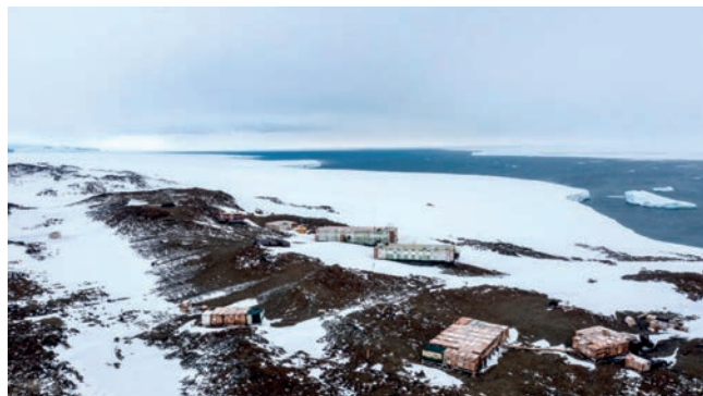
Общий вид на сезонную базу Русская в феврале 2020 года. Фото из архива РАЭ
