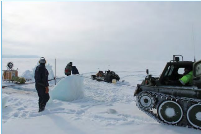
Термобуровые работы. Установка ледяных блоков для моделирования ледяного острова
