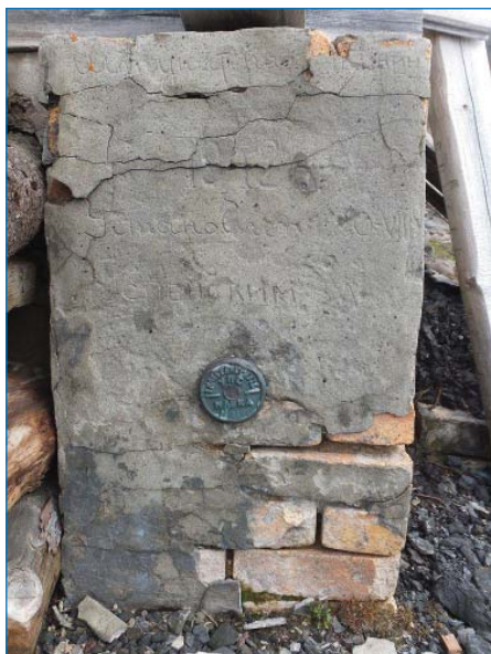
Нивелировочная метка в основании магнитного павильона п/ст «Бухта Тихая», установленная в 1942 году. Июль 2012 года. Фото автора
