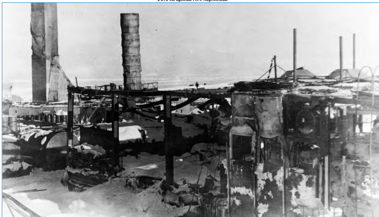
Останки дизель-электростанции на станции Восток после пожара. Фото из архива Н.А. Корнилова
