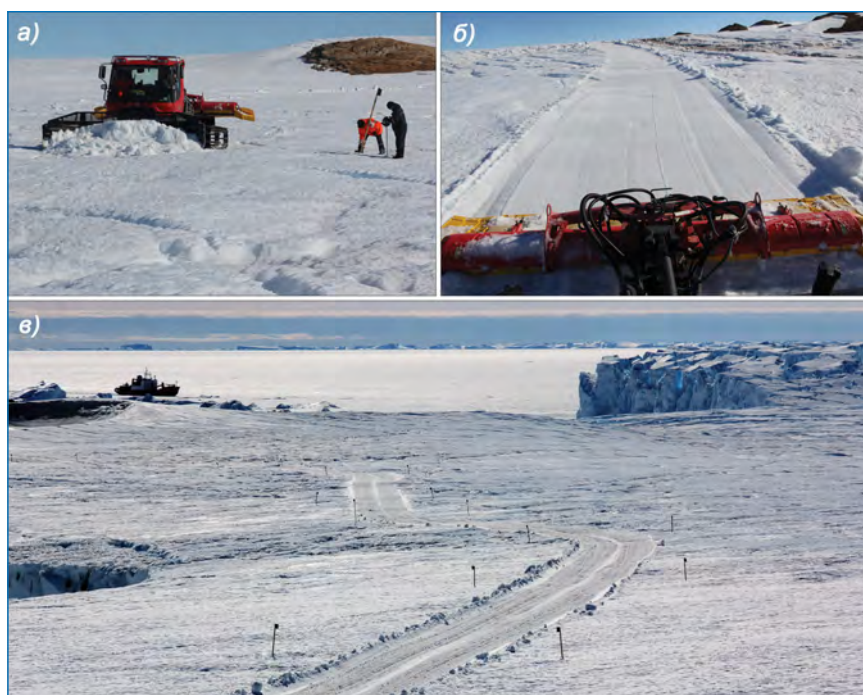
Рис. 4. Обвеховка и укатка новой трассы, проложенной в обход провала (а) и качество дорожного покрытия (б, в). Январь–февраль 2018 года. Фото. С.В. Попова
