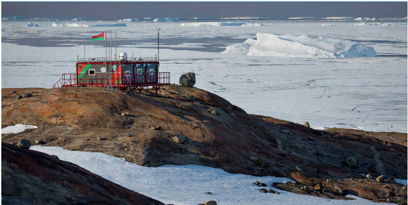
Общий вид первого модуля станции БАЭ «Гора Вечерняя»
