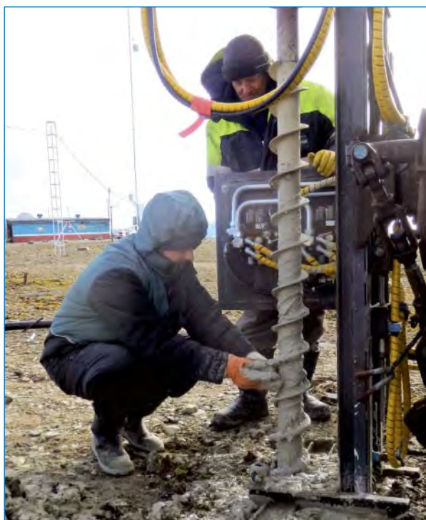
Бурение скважины для закладки грунтового репера на метеоплощадке НИС «Ледовая база "Мыс Баранова"»
