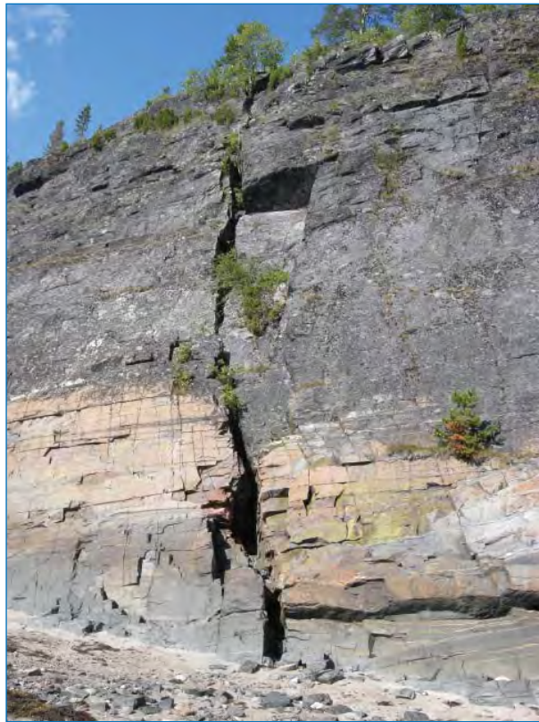
Рис. 1. Смещение кровли приливо-отливной зоны по тектонической трещине. Северный берег Кандалакшского залива.
