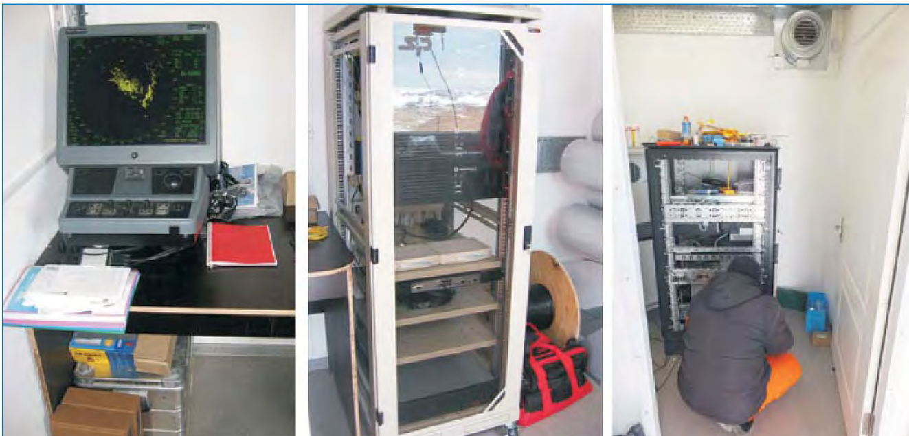
Размещение оборудования комплекса в верхнем модуле, слева направо: пульт управления радара «Bridge Master E», под столом навигационный спутниковый комплекс, стойка с оборудованием для ЗССС, ретрансляторы и фильтры УКВ связи, стойка ССИ СДКМ ГЛОНАСС.
